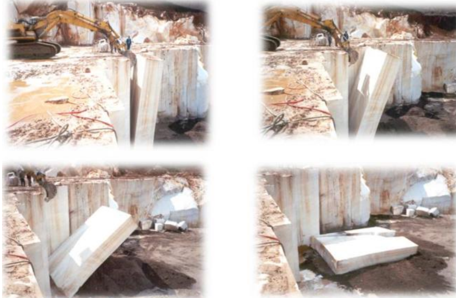
Слика 74: Соборување на работен блок со багер
