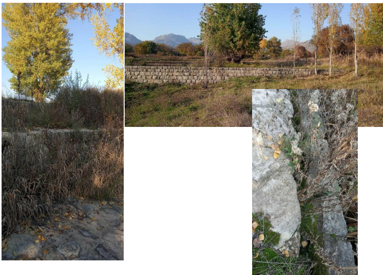
Сл. 11: Поглед на предметната преграда, трупот, слапиштето и оштетувањето на забот/појасот
