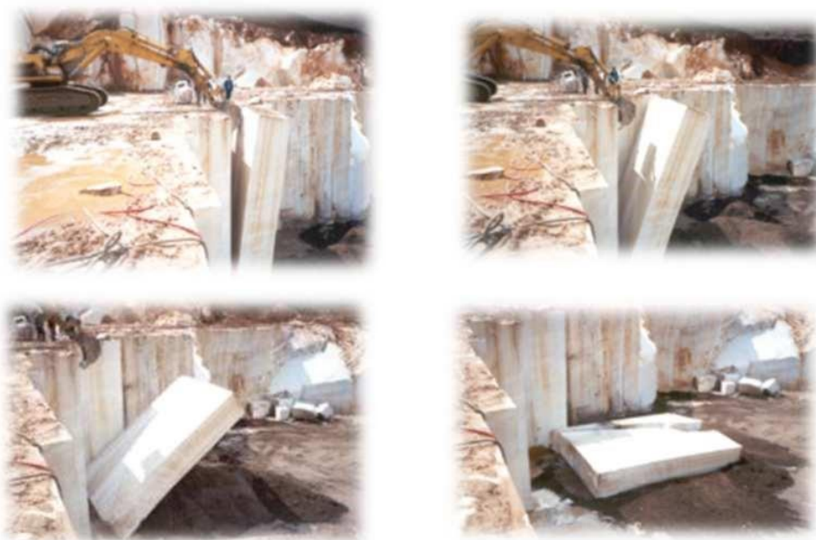
Слика 79: Соборување на работен блок со багер
