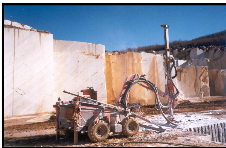
Слика 17. Дупчалка TAMROCK COOMANDO
