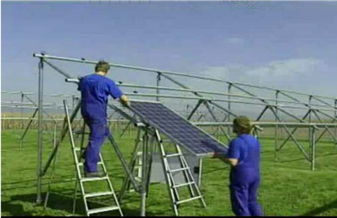
Монтажа на носечка конструкција и PV модули.
