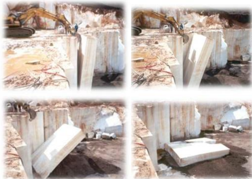
Слика 66: Соборување на работен блок со багер
