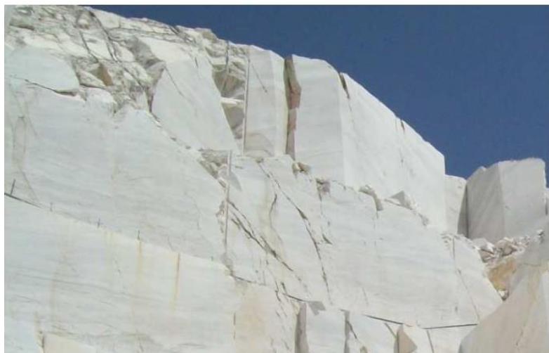
Слика 12: Мали пукнатини во површинските мермери во површинскиот коп “Сивец”
