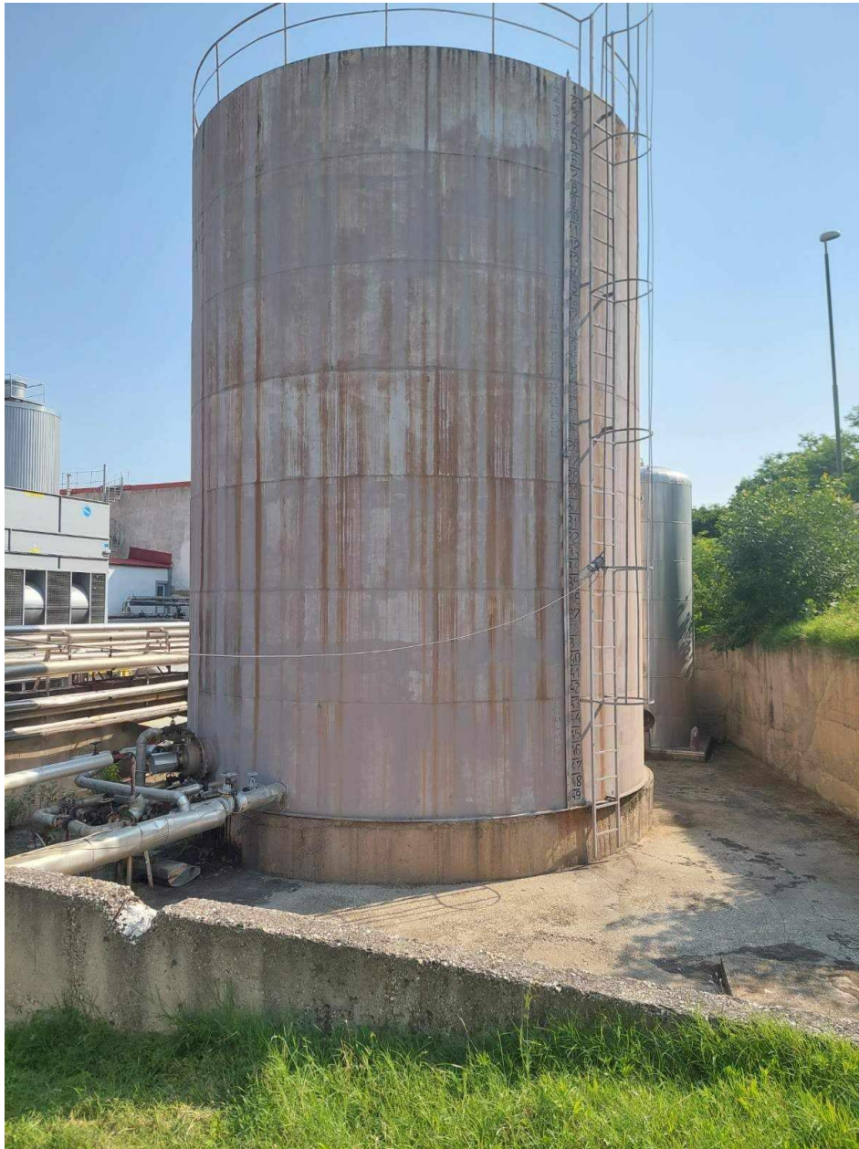
Слика 7 Резервоар за мазут
