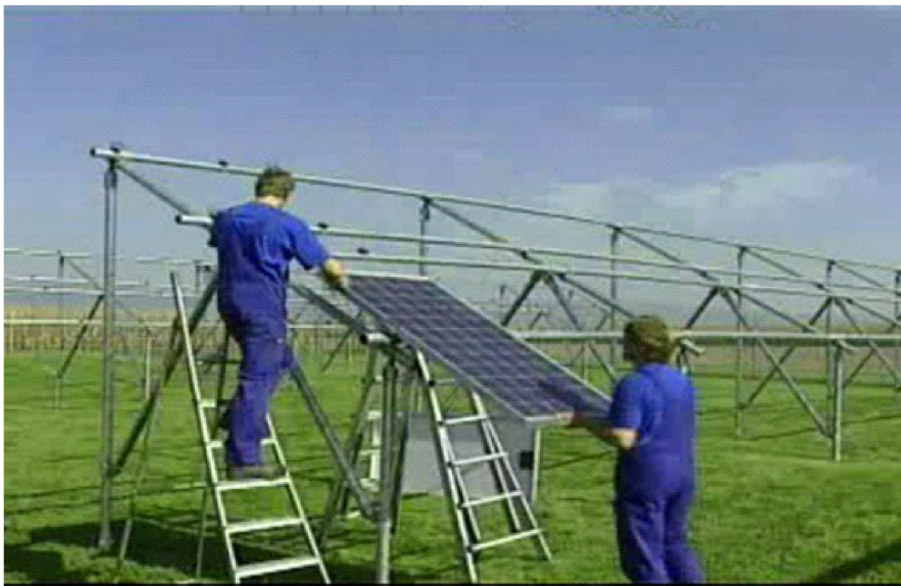
Монтажа на носечка конструкција и PV модули.
